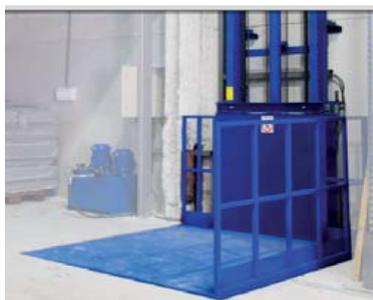
1.- Laterales de Protección: son protecciones o resguardos de 1.100 mm. de altura, en el contorno del elevador, que delimitan la superficie de carga, evitando el posible choque o enganche de la carga con el hueco.
