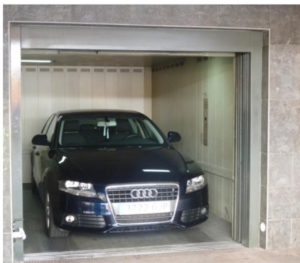
Diseñado y fabricado en acuerdo a los requerimientos de la **Directiva de Ascensores 95/16/CE**, a través del cumplimiento de la **Norma Armonizada EN 81-2** y la **Directiva de Compatibilidad Electromagnética 89/336/CEE**
