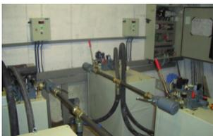
• **Central Doble Conmutada:** Sistema hidráulico complementario, enfocado al uso de montacoches. Se basa en la colocación de dos centrales hidráulicas interconectadas. Pueden funcionar al mismo tiempo, o tener una en caso de emergencia.
